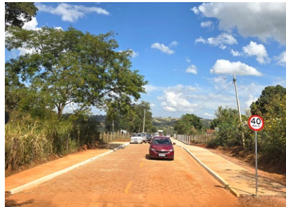
Pavimentação em bloquetes da Rua Edson Vaz Vieira.
