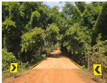
Ponte de concreto inaugurada no Povoado do Retiro
